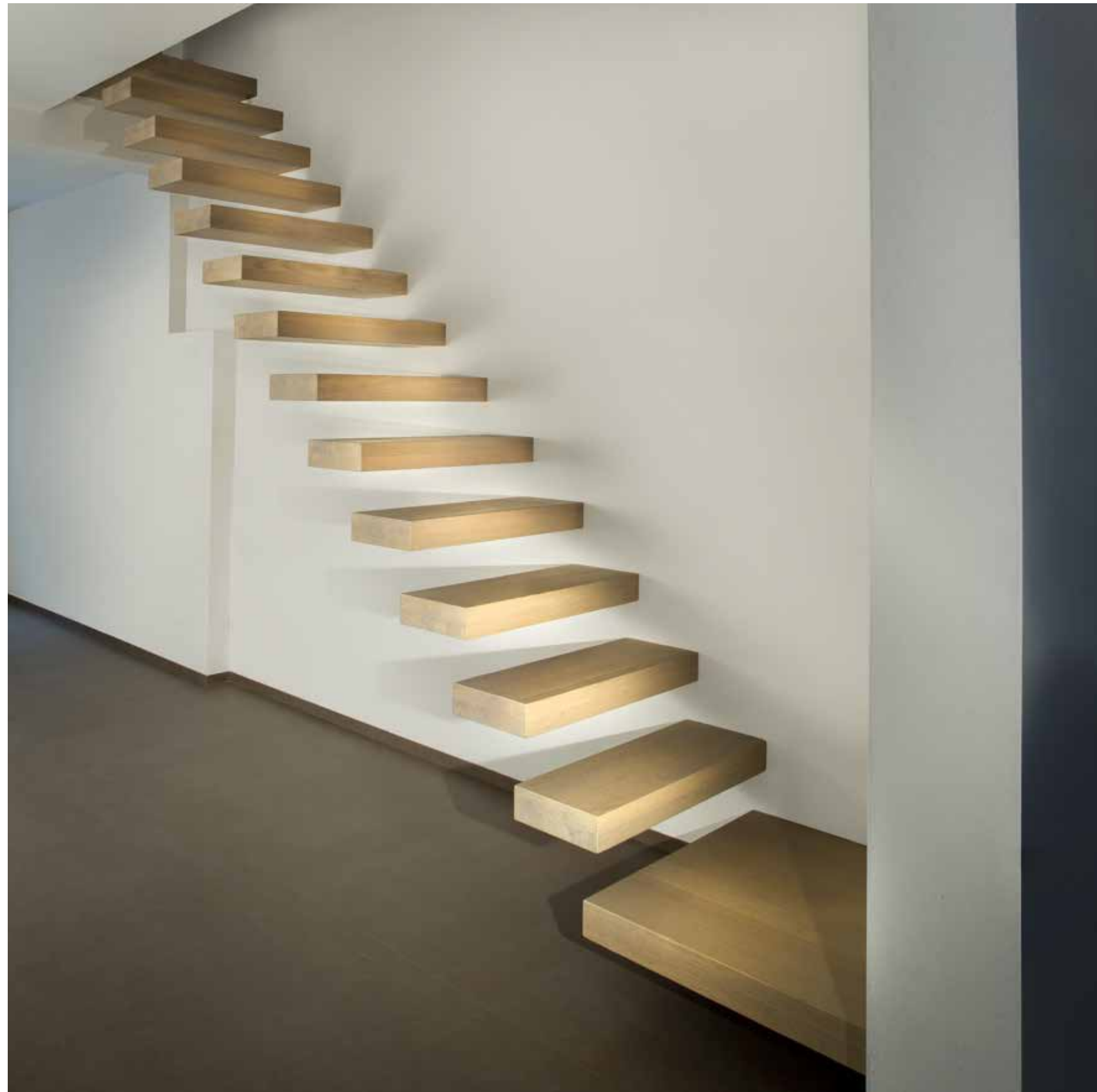
Scala a sbalzo a giorno senza sostegno laterale in rovere massello spazzolato e sbiancato. Open cantilever staircase without side support in solid brushed and bleached oak wood. Escalier à encorbellement à jour sans soutien latéral en rouvre massif brossé et blanchi. Offene Kragstufentreppe ohne seitliches Tragwerk, aus gebürstetem und gebleichtem massivem Eichenholz. Escalera en voladizo abierta sin soportes laterales, de roble macizo cepillado y blanqueado.
