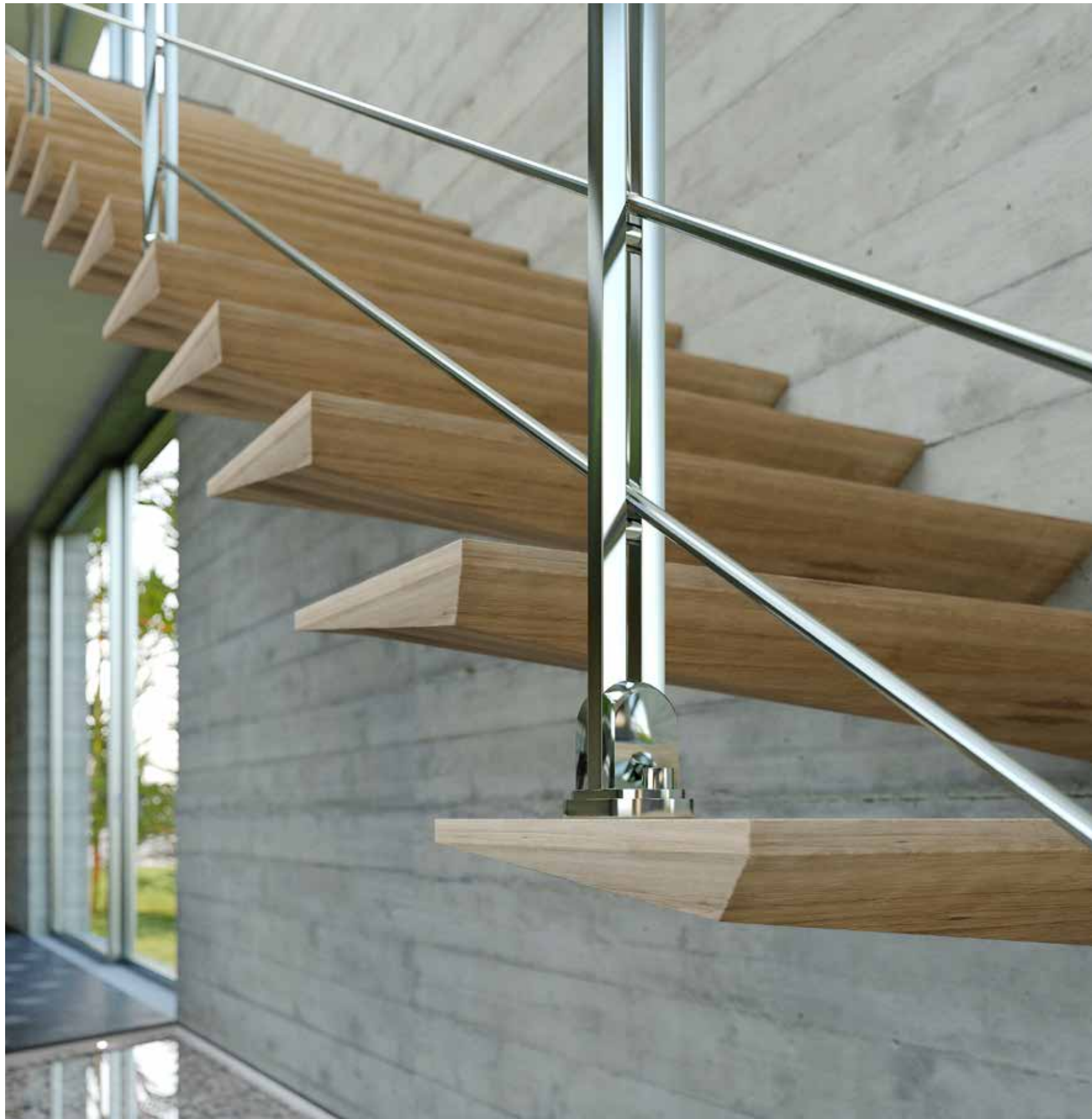
Scala "Diamante" con gradini a sbalzo in massello di rovere spazzolato senza puntalino e ringhiera in acciaio inox a tondini orizzontali. Staircase "Diamante" with cantilever steps in solid brushed oak wood without supports between steps and stainless-steel banister with horizontal rods. Escalier « Diamante » autoportant avec marches en rouvre massif brossé sans entretoises entre les marches et garde-corps en acier inox avec des lisses horizontales. Treppe „Diamante“ mit Kragstufen aus gebürstetem massivem Eichenholz ohne Stützen zwischen den Stufen, mit Geländer mit horizontalen Rundstäben aus rostfreiem Stahl. Escalera "Diamante" con peldaños en voladizo de roble macizo cepillado sin soporte entre peldaños y barandilla de acero inoxidable con barras horizontales.
