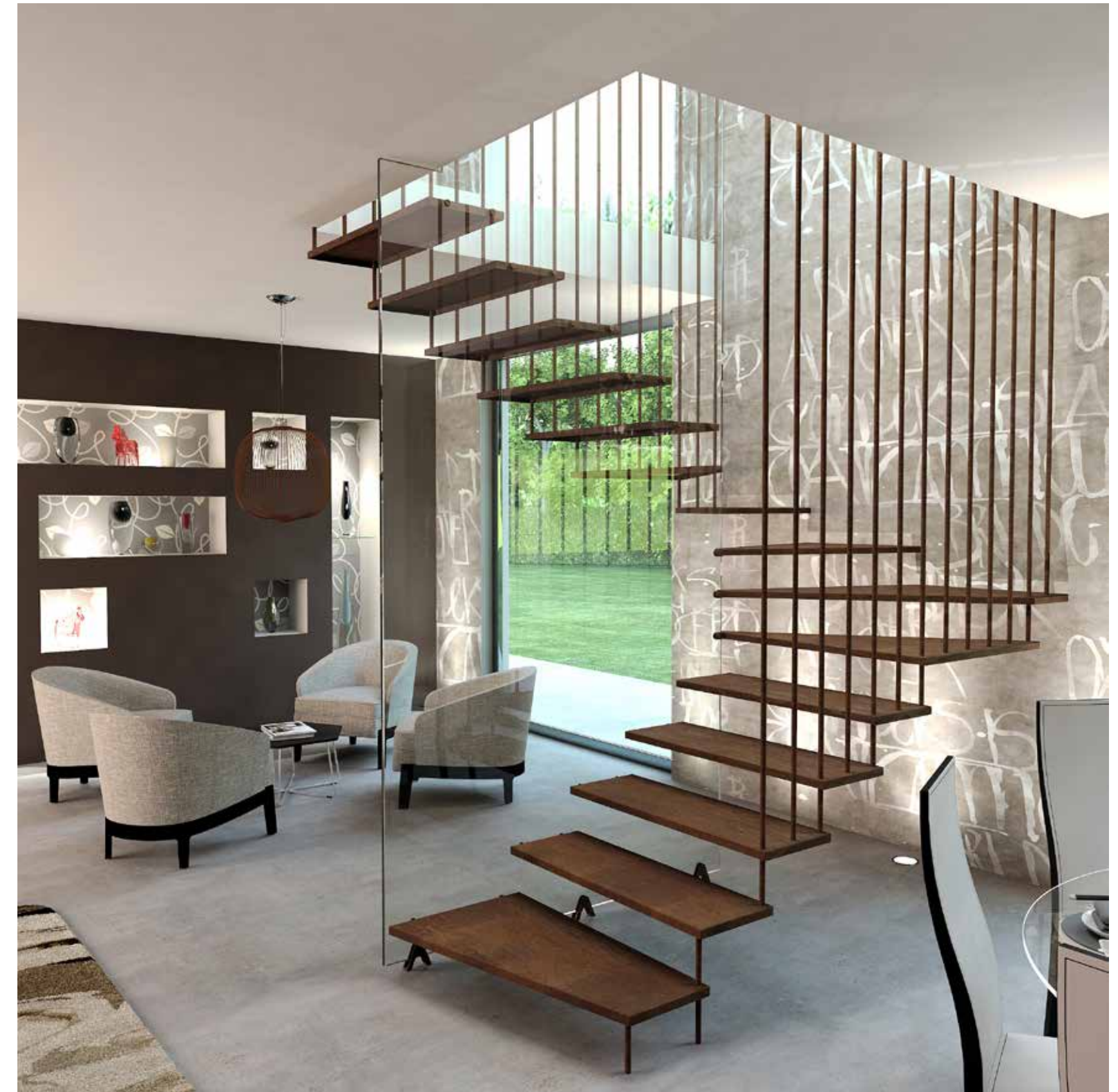
Scala a sbalzo con gradini e tiranti con corten e ringhiera centrale in cristallo strutturale extra chiaro. Cantilever staircase with steps and tension rods with corten steel, with central banister in extra-clear structural glass. Escalier autoportant avec marches et tirants avec acier corten et garde-corps central en cristal structuré extra-clair. Kragstufentreppe mit Stufen und Zugstangen mit Corten-Stahl und zentralem Geländer aus extraklarem Bauglas. Estalera en voladizo con peldaños y tirantes de corten. Barandilla central de cristal estructural extraclaro.
