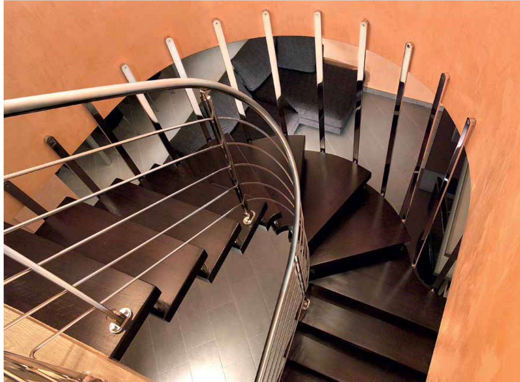
Scala a sbalzo a giorno ancorata al solaio con scalino in massello di rovere con finiture wengé e ringhiera a tondini orizzontali in acciaio inox. Open cantilever staircase, anchored to the floor, with steps in solid oak with wengé finish, and banister in horizontal stainless steel rods. Escalier ouvert à encorbellement ajouré, ancré au plancher, avec marches en bois de rouvre massif et des finitions en wengé et garde-corps à lisses horizontales en acier inox. An der Geschosdecke verankerte offene Kragstufentreppe mit Stufen aus massivem Eichenholz mit Wengé-Endbearbeitung und Geländer mit horizontalen Rundstäben aus rostfreiem Stahl. Escalera en voladizo anclada al forjado, escalones de roble macizo con acabado de wengé y barandilla con barras horizontales de acero inoxidable.
