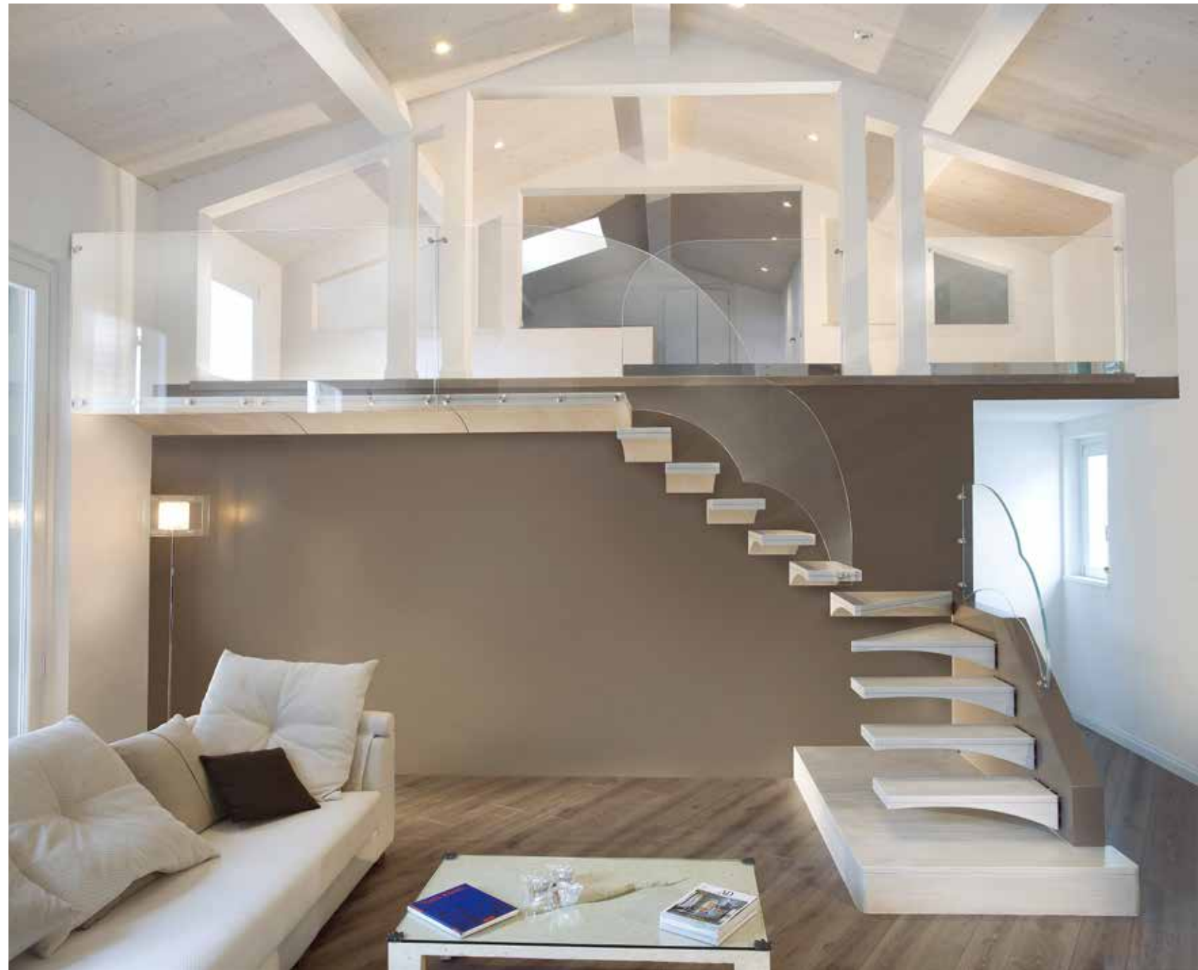
Scala a sbalzo con scalino modello ala di gabbiano rivestito in resina con ringhiera in cristallo sagomato temperato extra chiaro. Cantilever staircase with seagull-wing steps in resin-coated with banister in shaped extra-clear tempered glass. Escalier à encorbellement, modèle aile en mouette, revêtu de résine type travertin avec rambarde en cristal profilé, trempé extra clair. Kragstufentreppe mit harzbeschichteten Möwenflügel-Stufen und geformtem Geländer aus extraklarem Hartglas. Escalera en voladizo con peldaño modelo "ala de gaviota" revestido de resina tipo piedra de travertino, con barandilla de cristal perfilados, temperado extra claro.
